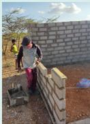
03 a 05/02: La construcción toma forma, ¡las paredes de la cocina van subiendo a pasos agigantados! A continuación, se colocan los postes de soporte de la construcción. ¡Estamos sorprendidos por el rápido progreso de este hermoso proyecto!
